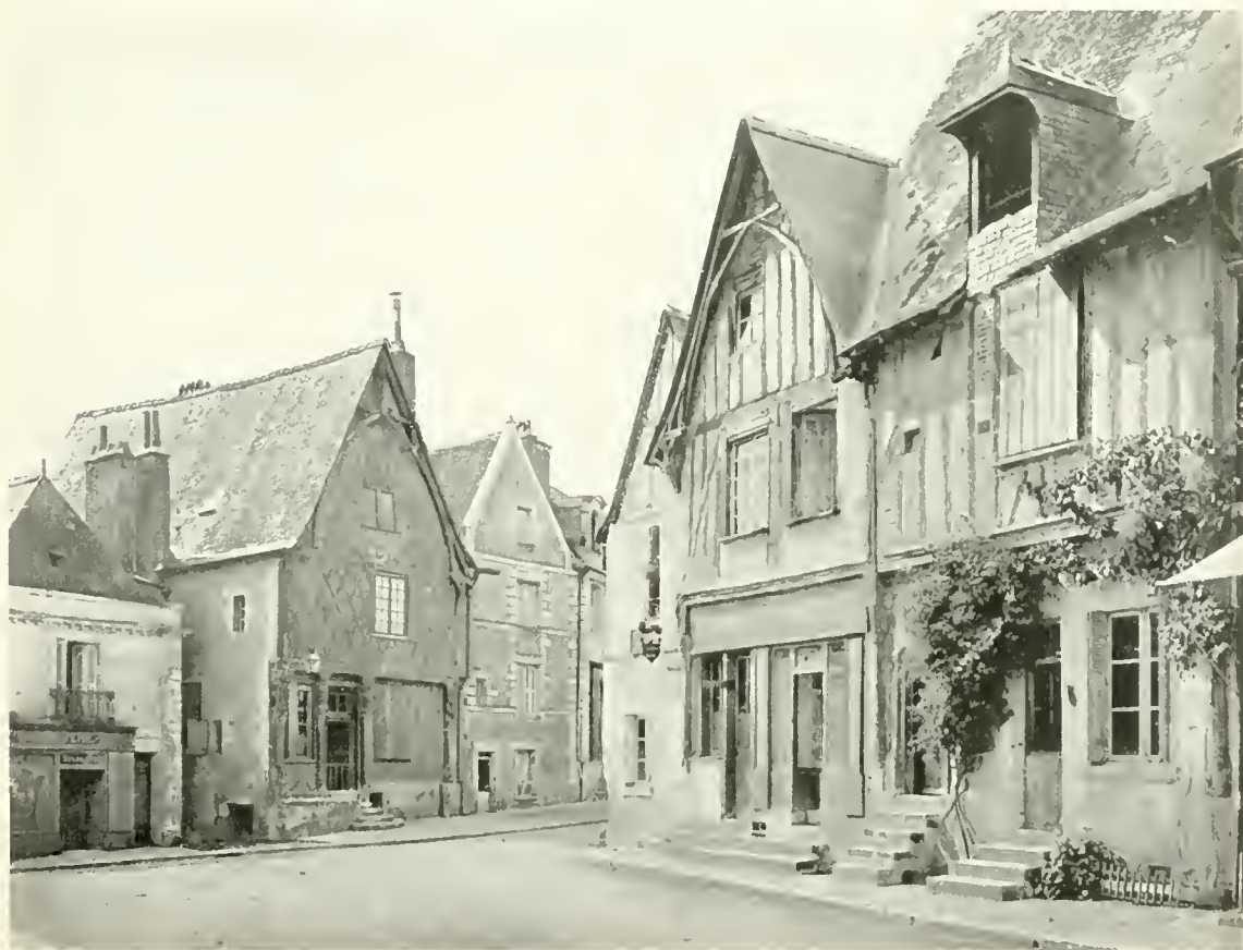
LUYNES—HOUSES ON PLACE DE L'ÉGLISE
